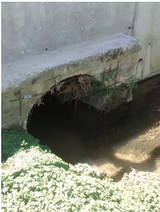
Figura 14: (sinistra) tombino di attraversamento DN600 con recapito nel vecchio scolo aeroporto interessato dai lavori delle casse di espansione, (sinistra) tubazione DN400 che prosegue sul lato Est di via Ferrarin verso viale Diaz. Le foto sono state scattate nel medesimo noto idraulico.
