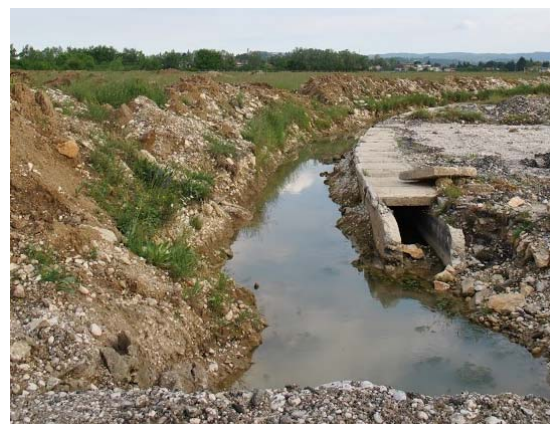
Figura 5: Fossi e scoli realizzati dall'impresa esecutrice della bonifica bellica per il drenaggio delle acque prima dello scarico su via Ferrarin (foto sx) ed in corrispondenza della bussola della pista (fosto sx) – 28.04.2015
