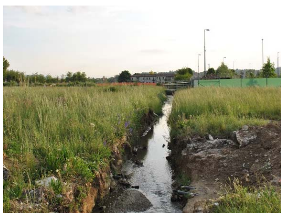
Figura 5: Fossi e scoli realizzati dall'impresa esecutrice della bonifica bellica per il drenaggio delle acque prima dello scarico su via Ferrarin (foto sx) ed in corrispondenza della bussola della pista (fosto sx) – 28.04.2015
