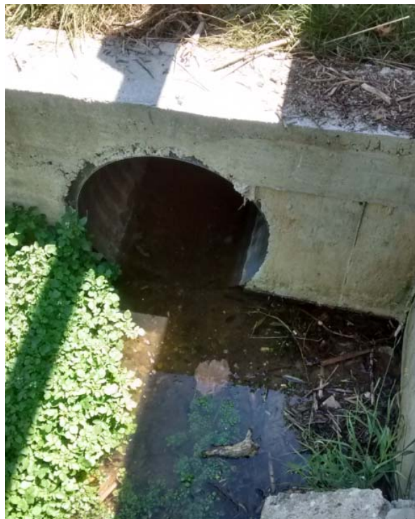
Figura 14: (sinistra) tombino di attraversamento DN600 con recapito nel vecchio scolo aeroporto interessato dai lavori delle casse di espansione, (sinistra) tubazione DN400 che prosegue sul lato Est di via Ferrarin verso viale Diaz. Le foto sono state scattate nel medesimo noto idraulico.
